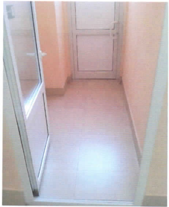
22. Тамбур эвакуационного выхода
