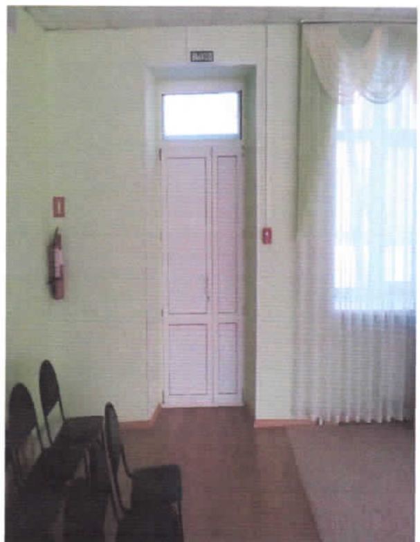
20. Эвакуационный выход из муз. зала
